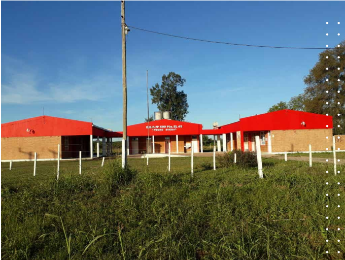
La escuela n° 599 de Tres Isletas se pintó gracias al trabajo realizado en las Comisiones Mixtas.
